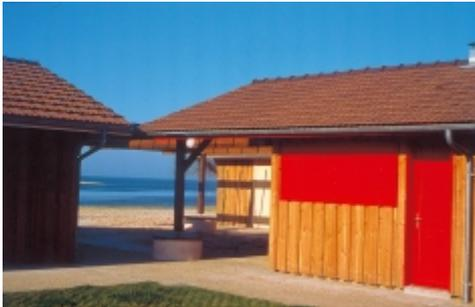
Tuile en terre cuite, de la famille des Grands Moules Faible Galbe, triple emboîtement, double recouvrement et pureau variable.
