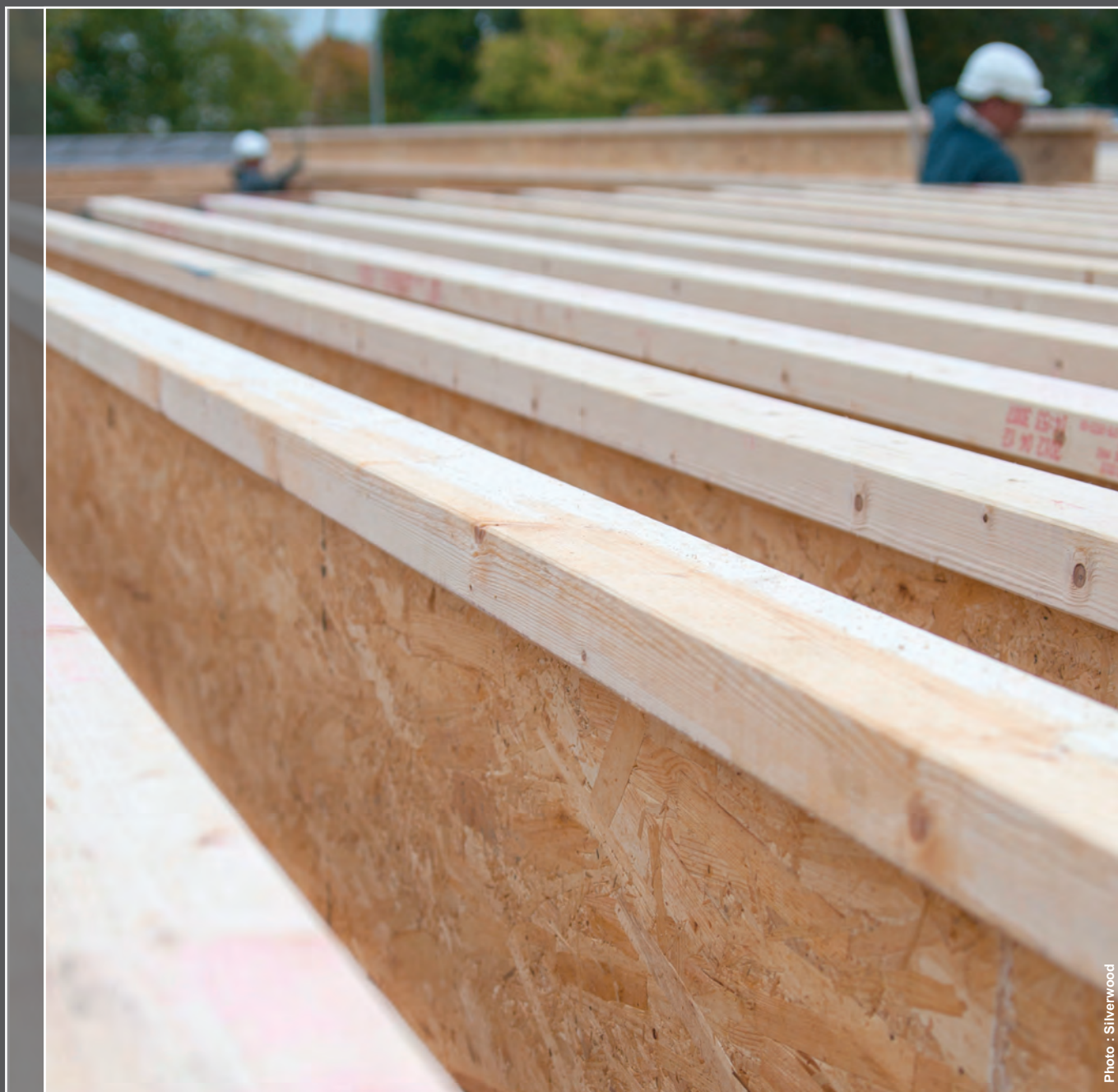
Poutres en I Swelite® utilisées en toit-terrasse
