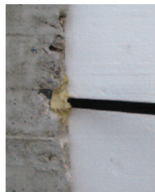
Gonds ISO à la résine sur béton
